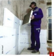
6 Moderne, kapillaraktive Innendämmungssysteme für Außenwände sollen in der Lage sein, die Luftfeuchtigkeit zu puffern und somit das Raumklima zu regulieren.
