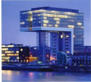
Das Kranhaus Plus am Köhlner Binnenhafen wird mit einer Betonkernaktivierung von Uponor gekühlt.
