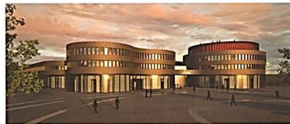
1 Die Leica Camera AG hat sich im Leitz Park architektonisch ein neues Gesicht geschaffen.
