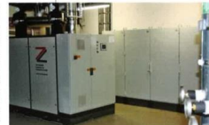
Die Energiezentrale nutzt die Energie des Erdreichs ganzjährig, um ohne Einbindung eines Pufferspeichers 2.120 m³ aktivierte Betonfläche zu kühlen und mit Heizwärme zu versorgen.
